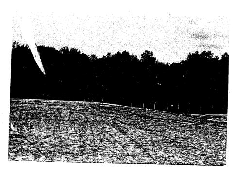
PLATE 3: CLAY CAP SURFACE AFTER SEALING WITH STEEL DRUM ROLLER
